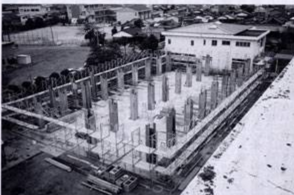
建築中の同窓会館 (左部分)
